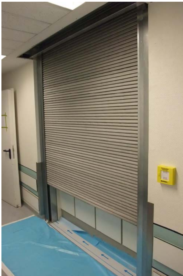
Abb.: Unter Brandeinwirkung wärmeisolierender Feuerschutzvorhang, Bildnachweis: Fa. Effertz Tore GmbH, Mönchengladbach
